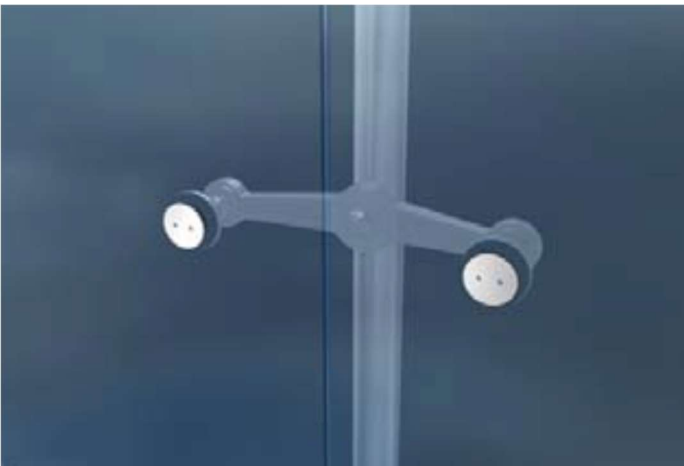
Transparan Cephe Sisteminde Kullanılan Çift Yönlü Bağlantı Elemanı
